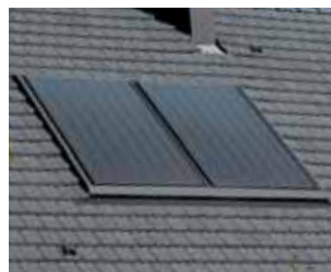
2 panouri solare verticale montate integrat in acoperis pe tigle mecanice
